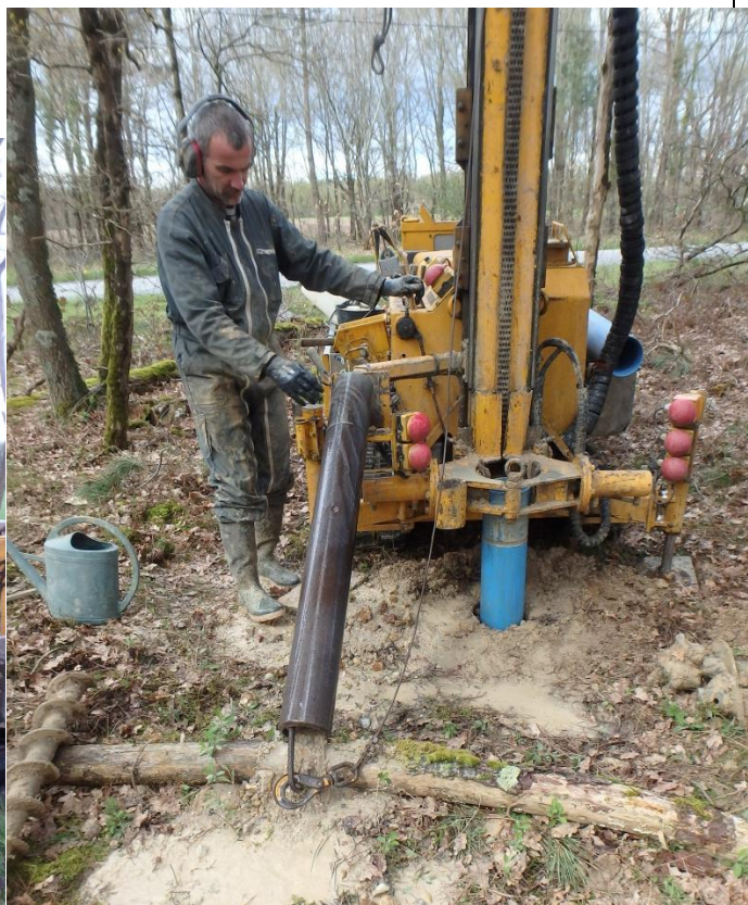
Pz2. Mise en place de l'équipement à l'aide de la soupape.
