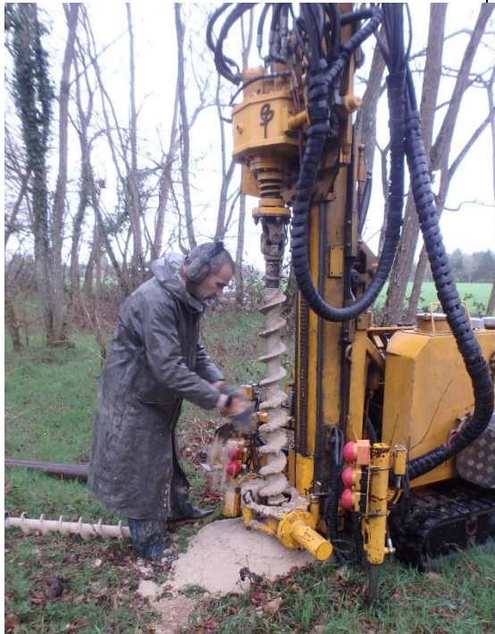
Pz1. Foration à la tarière sous le niveau de la nappe.
